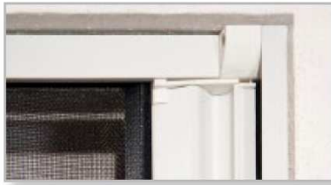
Profilerna kläms horisontalt. Montering utan skruv!
